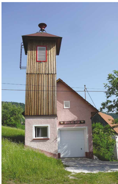
Obnovljen gasilski dom
